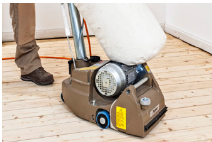
Fapadlók felújítása hüvelyes csiszolóval
