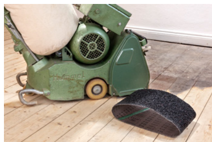
Fapadlók felújítása szalagcsiszolóval
